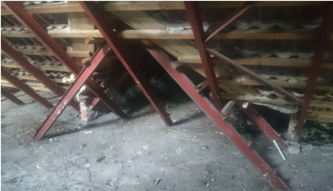
Gryfice ul. Armii Krajowej 39 – fragment stalowej konstrukcji dachu
