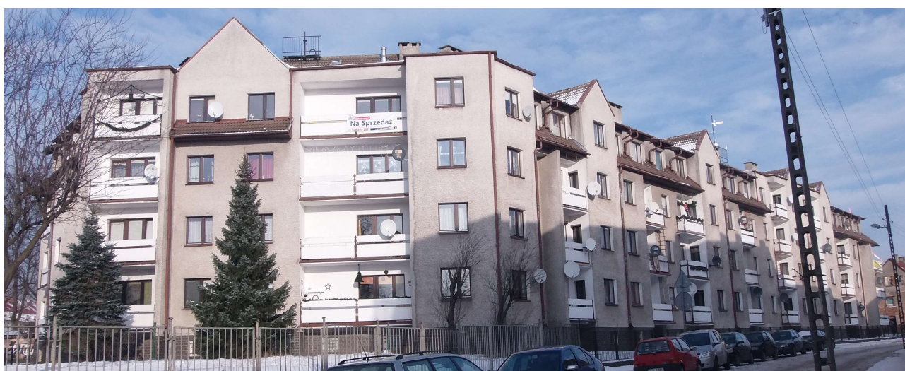
Gryfice ul. Armii Krajowej 39 – elewacja południowo-wschodnia i południowa
