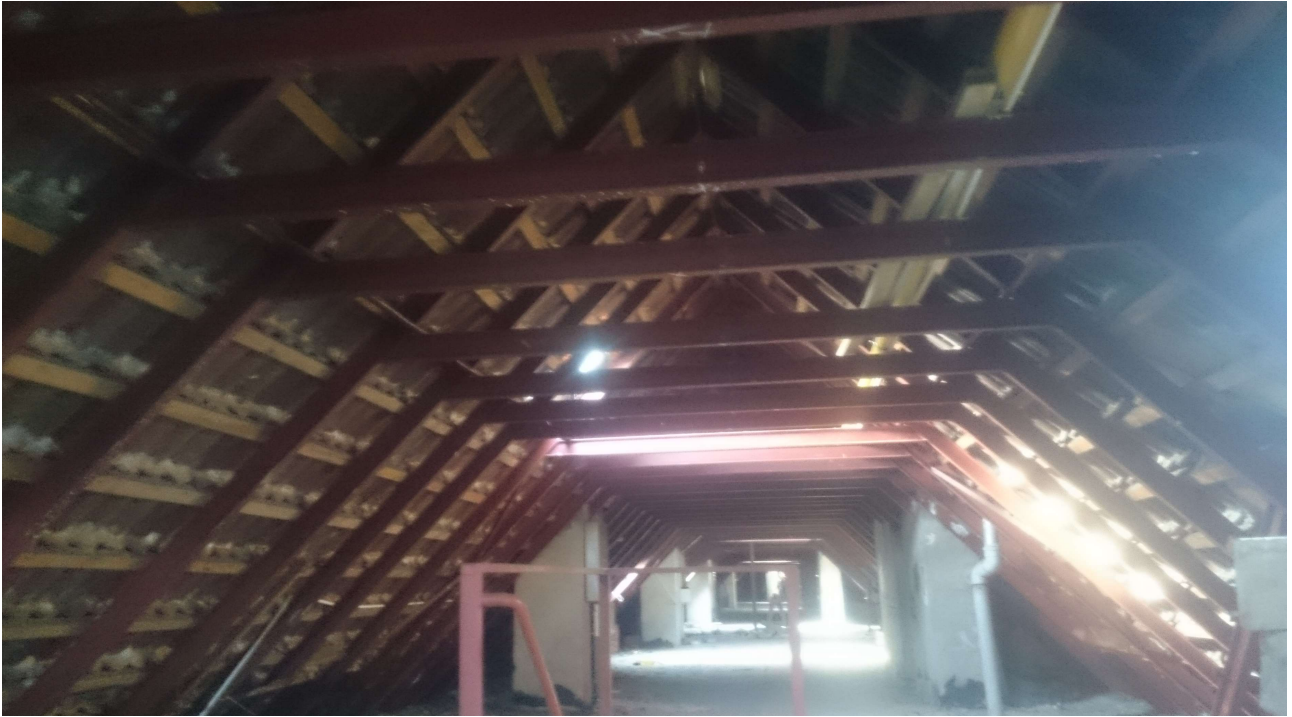
Gryfice ul. Armii Krajowej 39 – stalowa konstrukcja dachu
